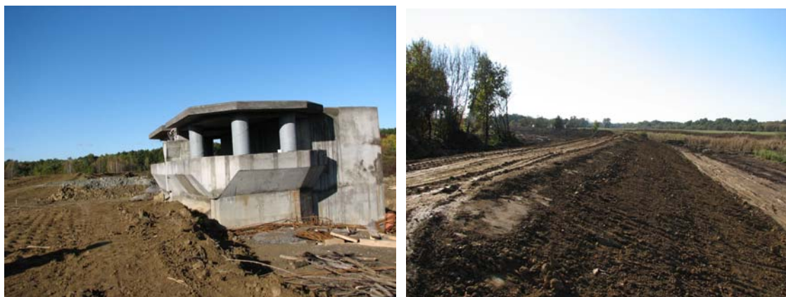
Zadrževalnik na Kobiljskem potoku v gradnji
