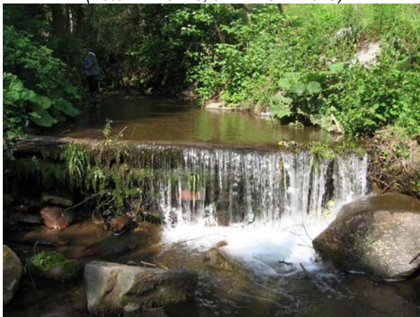
Ustalitveni prag na Požarskem jarku pred neurjem (Foto: R. Ferme, arhiv VGP Drava)
