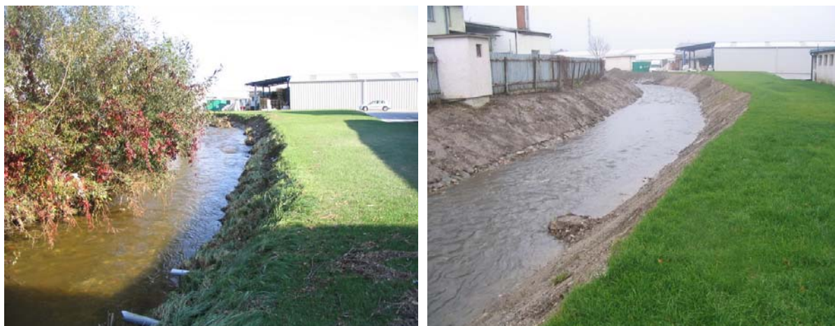
Pogled na desno, poškodovano brežino, gledano v dolvodni smeri (od mostu pri Oljarni proti Kartonaži) pred in po izvedbi del (Foto: R. Kuzmič, arhiv VGP Drava)
