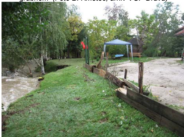
Dravinja v Dobrovljah, Dobrava 75, Mušič Poškodbe brežin, poplavljen stanovanjski objekt (Foto B. Kmetec, arhiv VGP Drava)
