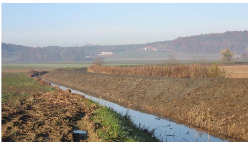
Nadvišanje nasipa v Velovleku (Foto: B. Kelenc, arhiv VGP Drava)
