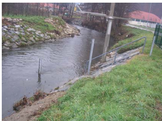
Ob AVP Loče so bila izvedena nujna interventna dela, nujno je nadaljevanje del na celotnem poškodovanem odseku (Foto: R. Kuzmič, arhiv VGP Drava)
