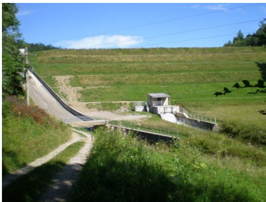
Slika 5. Pregrada Klivnik z izpustom vode
