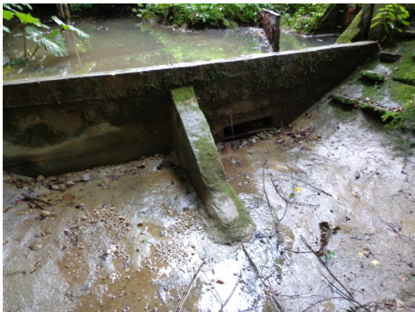
Slika 3: Zajezitev vodotoka na Lešnici in 97 % odvzem vse vode iz vodotoka za potrebe ribogojstva (Foto: Sabina Blumauer).
