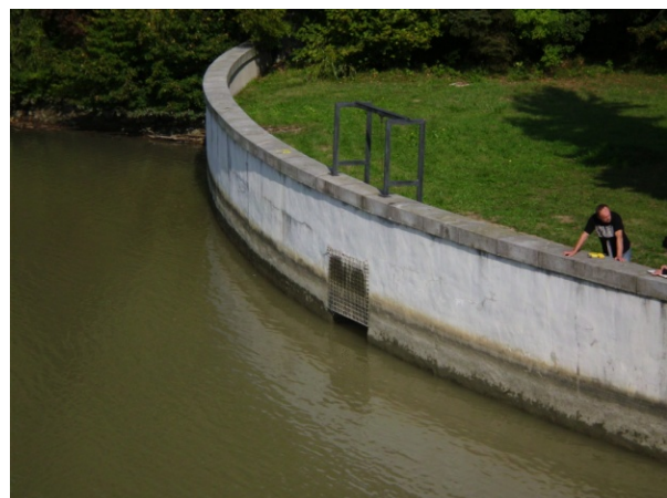
Slika 3: Vhod v ribjo stezo (levo) in izhod za ribe iz ribje steze oz. vtok v ribjo stezo HE Mariborski otok (desno) (vir: arhiv ZZRS).
