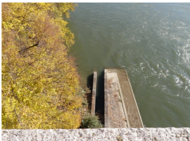
Slika 3: Vhod v ribjo stezo (levo) in izhod za ribe iz ribje steze oz. vtok v ribjo stezo HE Mariborski otok (desno) (vir: arhiv ZZRS).
